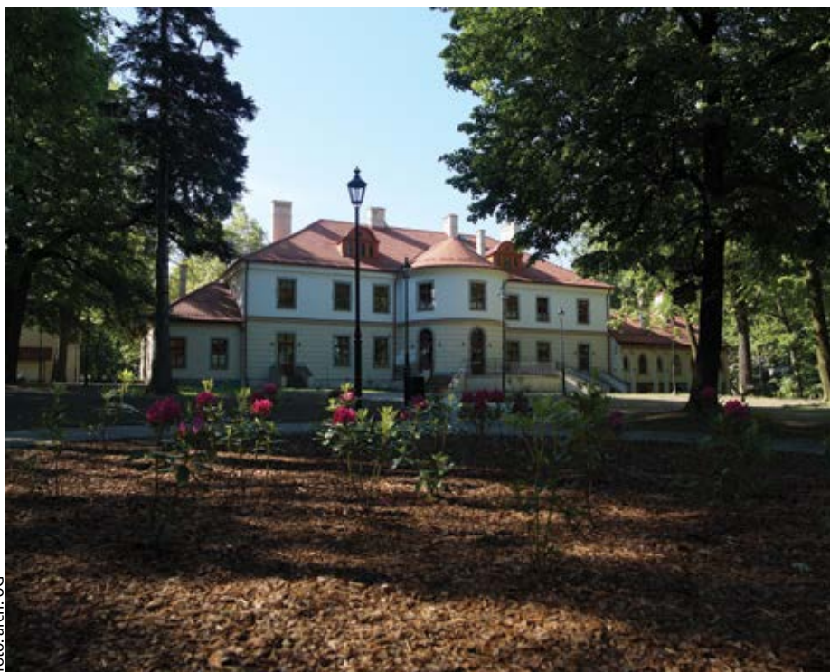
foto: arch. UG
