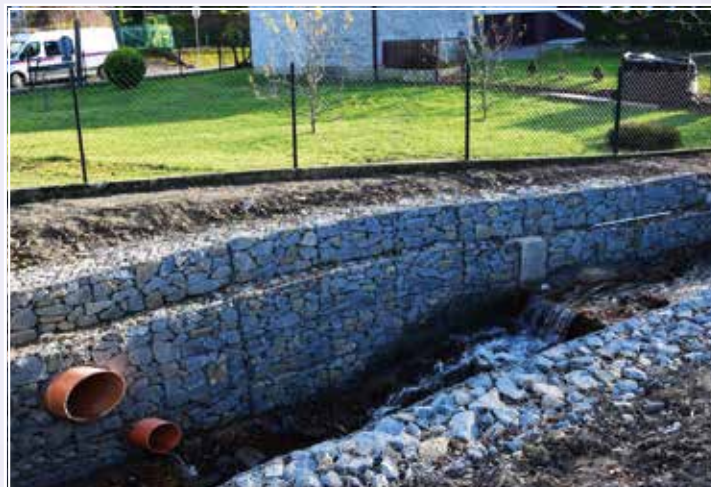
Przy obiektach mostowych odtworzono z siatek kamiennych zabezpieczenie linii brzegowej po obu stronach cieku.
