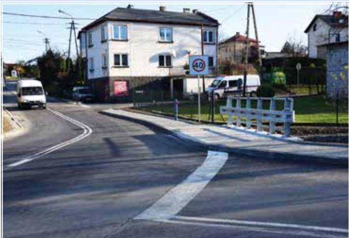
W ramach inwestycji kompleksowo przebudowano dwie przeprawy drogowe. W ciągu ulicy Panienki i przy skrzyżowaniu z ulicą Miłą.
