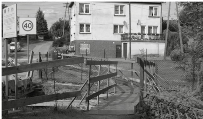
Konstrukcja betonowa mostu przy skrzyżowaniu z ulicą Panienki jest już gotowa. Na czas remontu przeprawy dla mieszkańców przygotowano specjalną kładkę.
