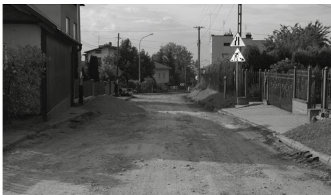
Na odcinku od ulicy Zamkowej do ulicy Panienki sfrezowano asfalt, częściowo usunięto stare chodniki dla pieszych. Wykonywana jest kanalizacja deszczowa i remont kanalizacji sanitarnej.
