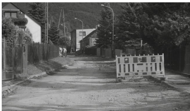
Na odcinku od ulicy Zamkowej do ulicy Panienki sfrezowano asfalt, częściowo usunięto stare chodniki dla pieszych. Wykonywana jest kanalizacja deszczowa i remont kanalizacji sanitarnej.
