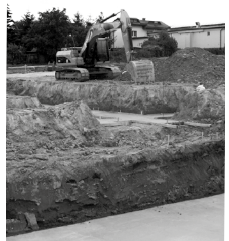
Pierwsze podłoża pod fundamenty nowego przedszkola zostały już przygotowane
