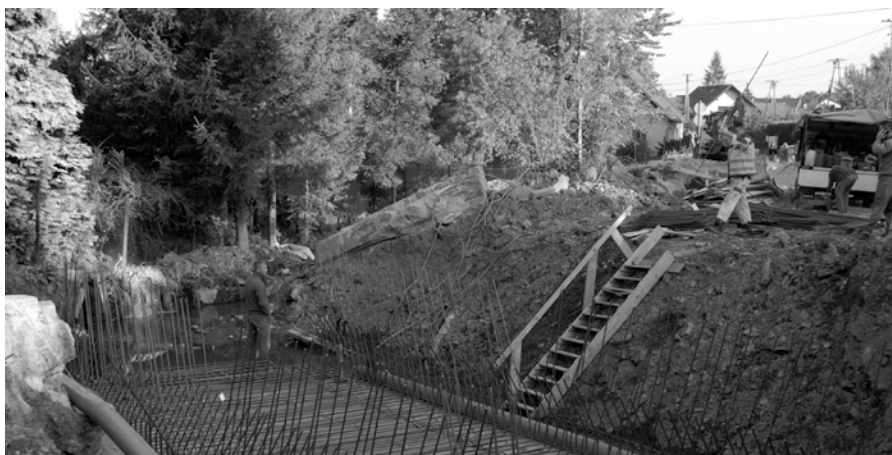
Od podstaw budowany jest obiekt mostowy przy skrzyżowaniu z ulicą Miłą
