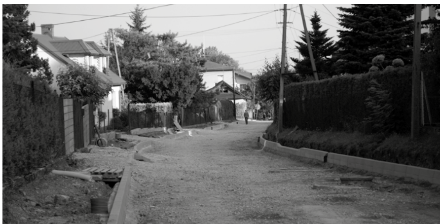
6. metrowa jezdnia została wytyczona, z obu stron drogi zabudowano krawężniki
