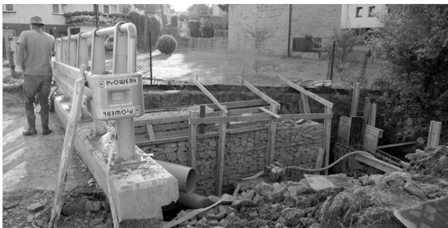
W ramach prac umacniane są brzegi Kozłówki w rejonie ukończonego mostu przy ul. Panienki
