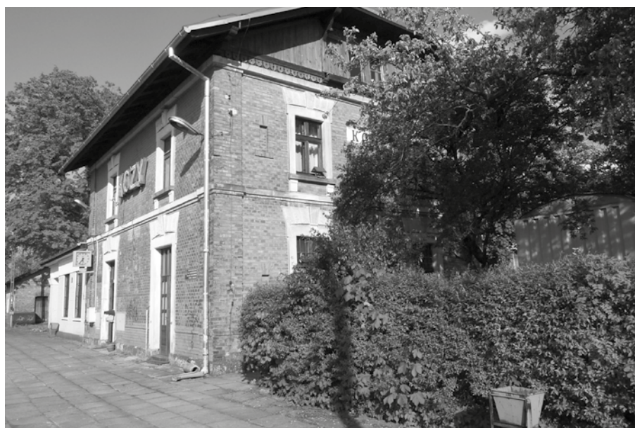
Budynek dworca kolejowego w Kozach
