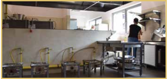
Kuchnia do przygotowywania posiłków wraz z zapleczem magazynowo-socjalnym
