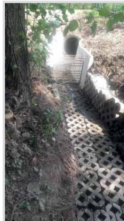
PRZEPUST POD UL. CMENTARNĄ
