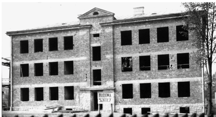
Szkoła w budowie
