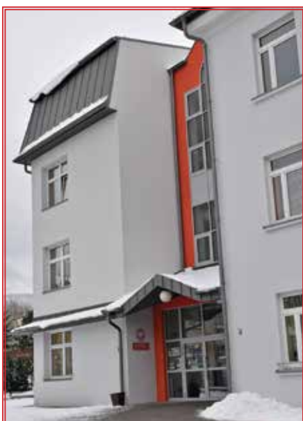
Nowa witryna aluminiowa, nowy daszek nad wejściem, ocieplenie elewacji oraz likwidacja schodów
