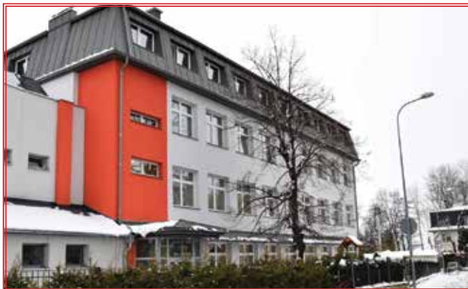
Nowa stolarka okienna, nowe pokrycie dachu, ocieplenie elewacji
