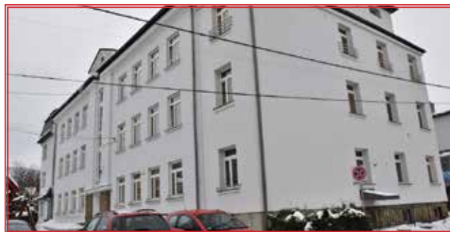
Decyzją konserwatora zabytków elewacja na tzw. starej części szkoły nie została ocieplona, otrzymała natomiast nową kolorystykę
