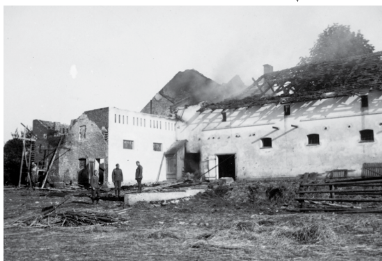
▼ Stan zniszczeń spichlerza i obory dworskiej (fot. ze zbiorów TMHiZK)
