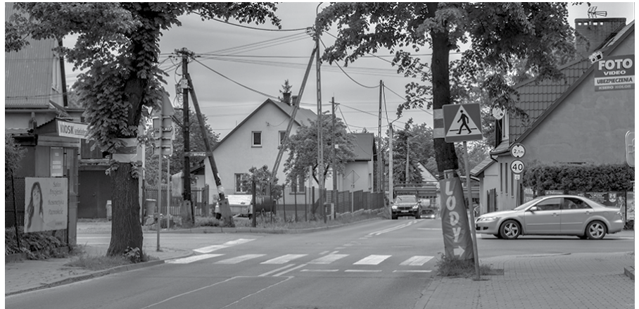
Skrzyżowanie ulic Kościelnej, Dworcowej, Nadbrzeżnej i Młyńskiej dzięki zabudowie wyniesionych przejść dla pieszych stanie się znacznie bezpieczniejsze
