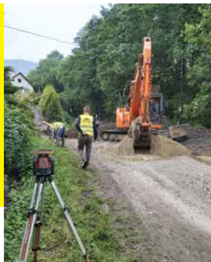
Postępują prace na ulicy Południowej, gdzie realizowana jest sieć kanalizacyjna w ramach zadania nr 4
