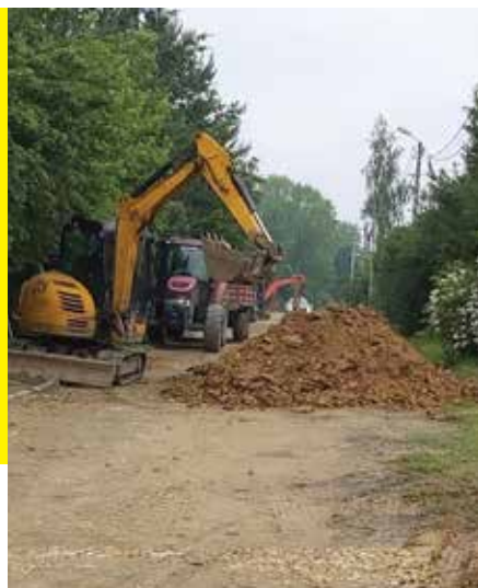
Realizacja kanalizacji na ulicy Krzemowej w ramach zadania nr 3
