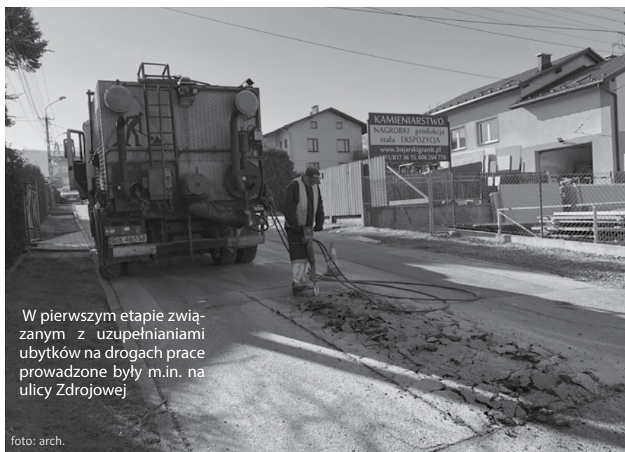
Nowa nawierzchnia bitumiczna i wytyczone miejsca parkingowe – to główne zamierzenia remontu ulicy Wspólnej
