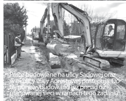
W ramach zadania nr 5 kanalizacja realizowana jest w ulicy Białej
