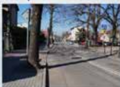
drogi i chodniki
