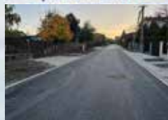
drogi i chodniki
