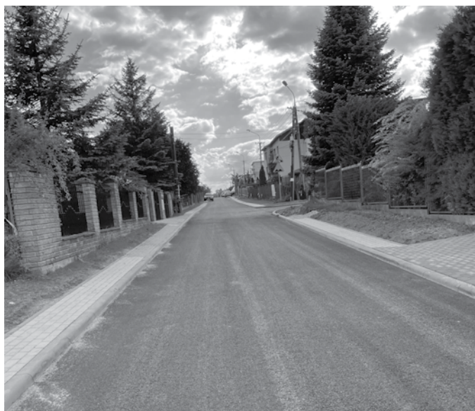
W ramach ulicy Bukietowej trwają prace z układaniem nawierzchni asfaltowej oraz zabudową poboczy i zjazdów do posesji.
