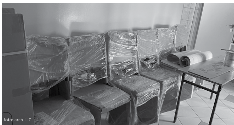
Wakacyjny okres to w liceum również czas remontów - sal lekcyjnych, korytarzy, jak i całego zaplecza dydaktycznego.
